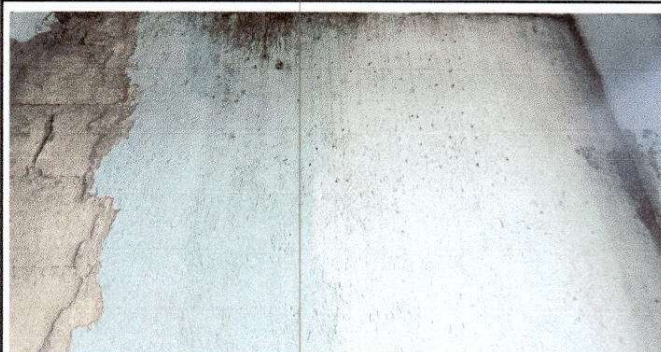
Foto 10: Repello en muro (quitar repello + refuerzo de pared + repello nuevo)
