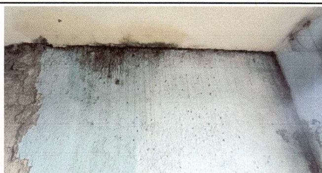
Foto 10: Sellado de grietas y fisuras en muros
