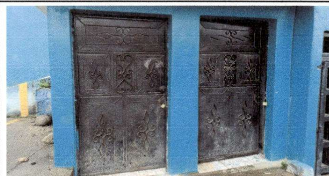
Foto 3: Sustrucción de puerta en servicio sanitario
