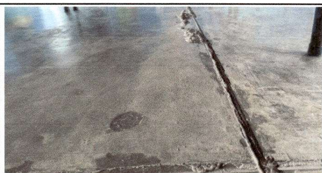
Foto 5: Sustrucción de piso cerámico
