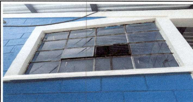
Foto 4: Mantenimiento a estructura de metal de ventana + Sustrucción de vidrios
